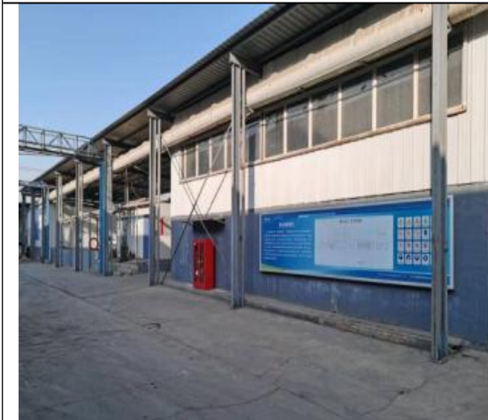
综合污水处理站
