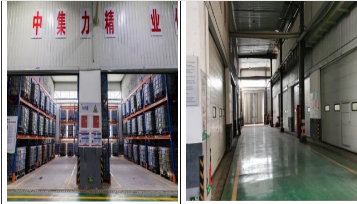
危废暂存库内部
